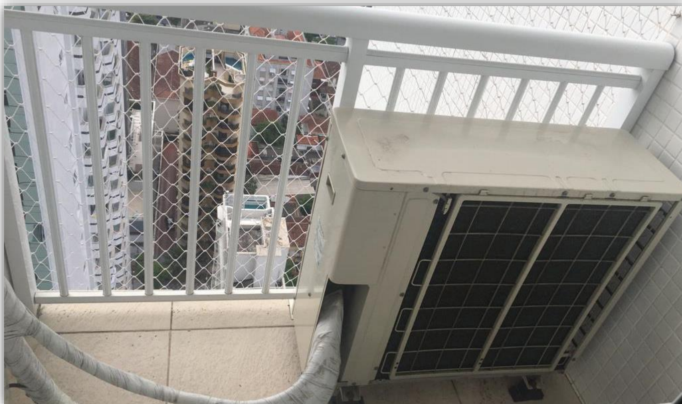
Exemplo de Terraço técnico – Edifício no bairro Pompéia, em Santos/SP
