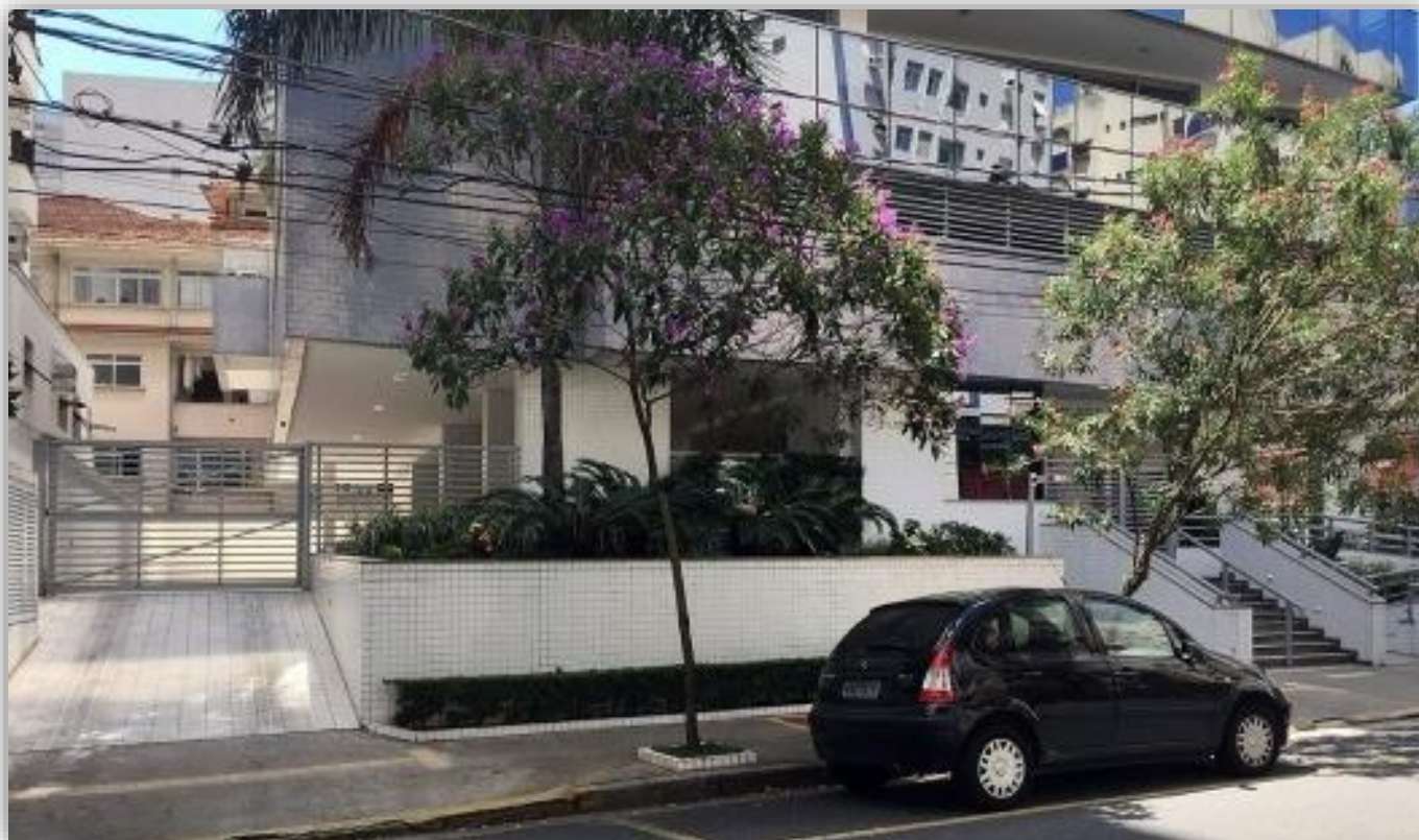
AFLORAMENTO, edifício em Santos-SP
