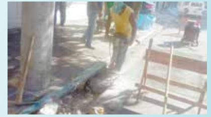
Reparo em sarjeta na Rua Saturnino de Brito - Marapé
