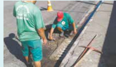
Troca de grelhas na Av. Martins Fontes - Sabão
