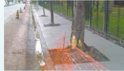
Novas calçadas em concreto desempenado no entorno do Teatro Municipal - Vila Mathias
