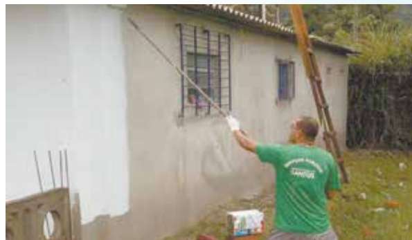
Serviços de pintura externa do salão e concretagem do piso externo na Soc. Esp. de Caruará
