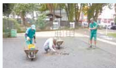
Reparo em piso em mosaico na Praça Caio Ribeiro de Moraes e Silva - Aparecida
