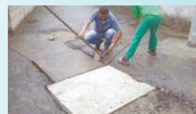
Troca de tampa de galeria na Rua Teodoro Sampaio - Jabaquara
