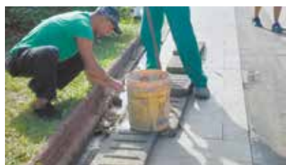
Limpeza das grelhas no Emissário
