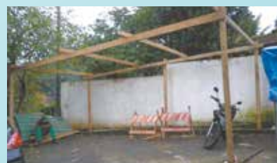
Construção de telhado em frente à Escola Lúcio Floro - José Menino
