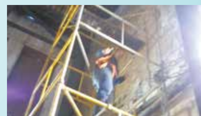
Retirada de reboco solto na Frontaria Azulejada - Centro
