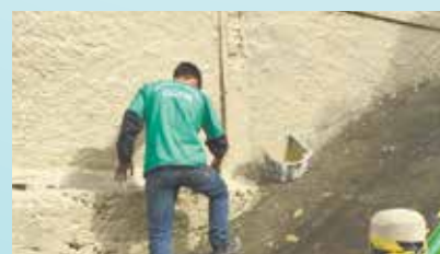
Pintura de muros, corrimãos e guarda-corpo na Rua São João - São Bento
