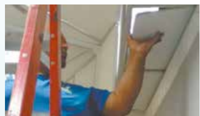
Colocação de forros no prédio da Seges na Rua Dom Pedro II - Centro
