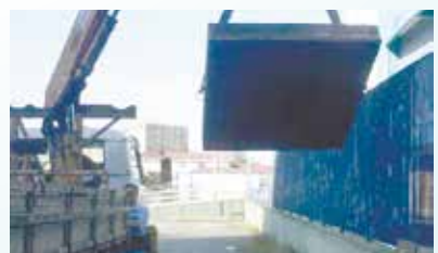
Colocação de lage pré-moldada para poço de visita na Arena Santos - Vila Mathias
