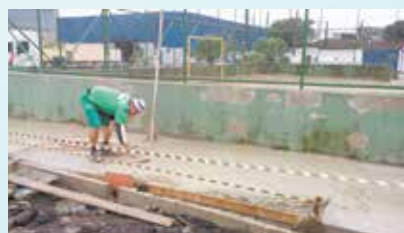
Concretagem do piso defronte à arquibancada na Praça Guilherme Delius - Vila Haddad
