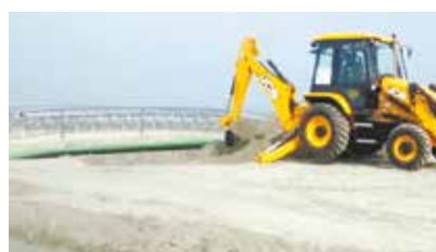
Início da retirada da areia de dentro do Canal 3 - Gonzaga
