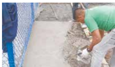
Concretagem da calçada na praça - Monte Cabrão
