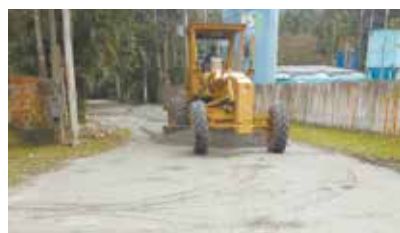
Nivelamento com bica corrida na Rua Tupi - Caruara
