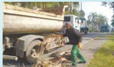
Limpeza do Elevado Aristides de Bastos Machado
