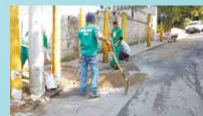
Reparos e manutenções na Rua São João - São Bento
