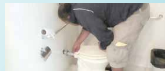
Troca de vaso sanitário UME Eunice Caldas - Vila Belmiro
