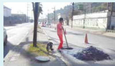
Limpeza de galerias de águas pluviais na Av. Nossa Senhora de Fátima - Chico de Paula
