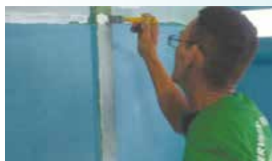
Pintura de banheiros na UME Judoca Ricardo Sampaio - Caruara
