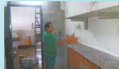
Pintura interna do refeitório e quartinho de materiais na UME Bandeira Brasil - Bom Retiro
