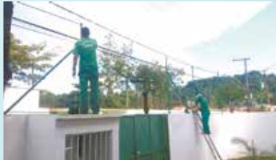
Pintura da estrutura do alambreado da Policlínica Bom Retiro
