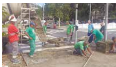
Concretagem do passeio da Praça Gomide Ribeiro - Embaré
