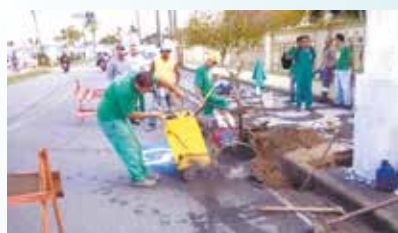
Execução de travessia de dutos para instalações elétricas no Deck do Pescador - Ponta da Praia
