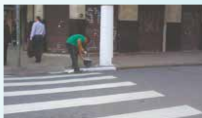
Pintura de postes e guias na Rua Dom Pedro II - Centro
