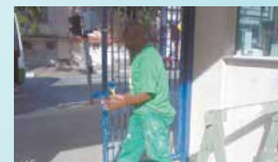
Pintura de portão e grades na Arena Santos - Vila Mathias
