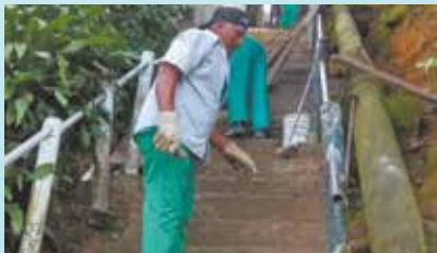
Manutenção de guarda-corpo e Escadaria São Domingos - São Bento
