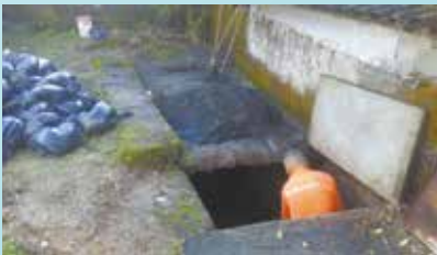
Limpeza de drenagem na Rua José Hilário dos Santos - Nova Cintra
