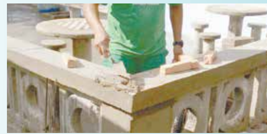
Reboco da mureta e cabeceira na Sociedade Esportiva Caruará
