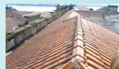
Troca de telhas e cumieiras prédio da Procuradoria Fiscal - Centro
