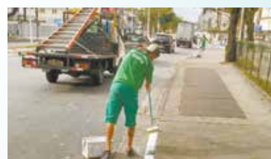
Pintura de postes e entrada das ruas na Av. Afonso Pena - Embaré
