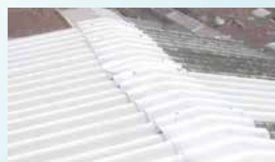
Serviços no telhado do Mercado Municipal - Vila Nova
