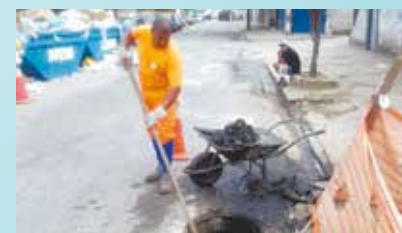
Limpeza de poços de visita e bocas de lobo na Rua Caminho São Jorge - Caneleira
