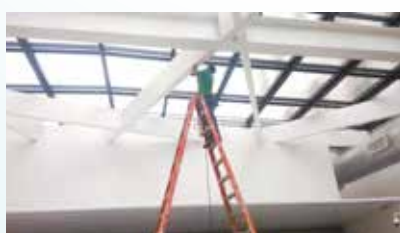
Recolocação de lâmpadas LED no Museu Pelé - Valongo
