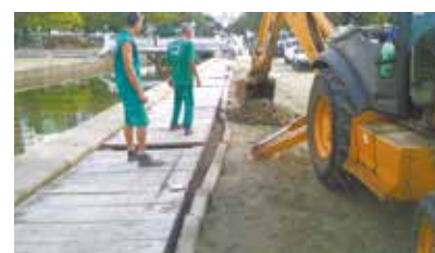
Renivelamento de Guias da passarela acessível na praia ao lado do Canal 1 - José Menino
