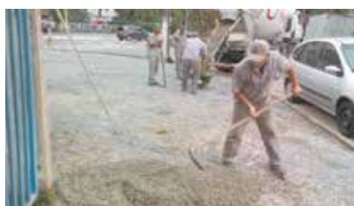
Concretagem da calçada da Av. Afonso Pena com Rua Liberdade - Aparecida
