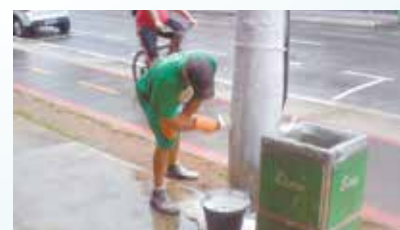
Pintura de postes na Rua João Pessoa - Centro
