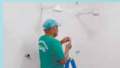
Manutenção em chuveiros no almoxarifado da Subprefeitura dos Morros - Nova Cintra
