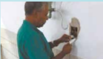
Manutenção em interruptores na Escola Rubens Lara - Nova Cintra
