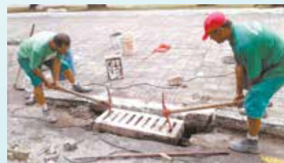
Colocação de boca de lobos na Av. Getúlio Vargas - Valongo
