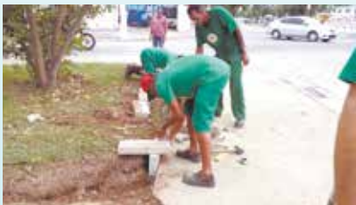
Assentamento de cordonéis na Praça Albertino Moreira - Caneleira
