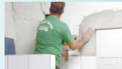
Rejunte nos revestimentos e lixamento de paredes para pintura geral na Soc. Esp. do Caruara
