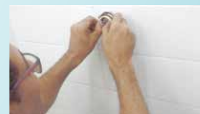
Conserto vazamento da Coetel - Centro
