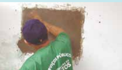
Reparo em paredes na Sociedade de Melhoramentos - Monte Serrat
