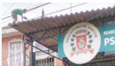
Troca de telhas francesas e cumeeiras na Rua da Constituição - Paquetá
