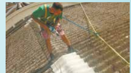
Troca de telhas e cumeeiras anexo Mercado Municipal - Vila Nova
