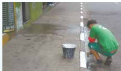
Pintura de guias Av. Senador Feijó - Centro
