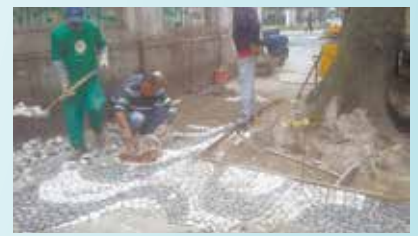
Reparo em calçada danificada por raízes de árvores na Rua Carlos Afonseca - Gonzaga
