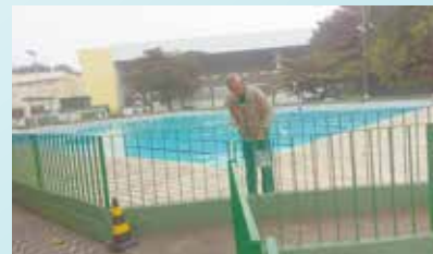
Pintura do gradil do Complexo Poliesportivo M. Nascimento - Bom Retiro
