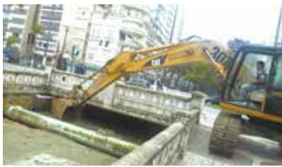
Desassoreamento do canal 3 - Gonzaga
