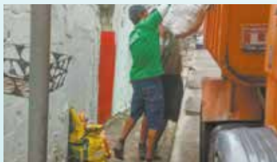
Limpeza e retirada de entulhos na Rua Manoel Ferramenta Jr - Areia Branca
