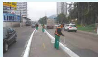
Pintura de guias e poste Av. Martins Fontes - Saboó
