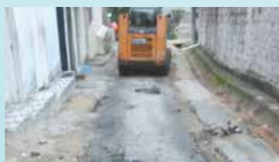
Pavimentação na viela do Morro do José Menino
