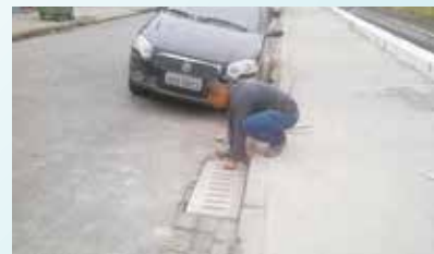
Troca de bocas de lobo na Rua Campos Salles - Vila Nova
