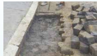
Renivelamento na Rua Anhanguera - Vila Mathias
