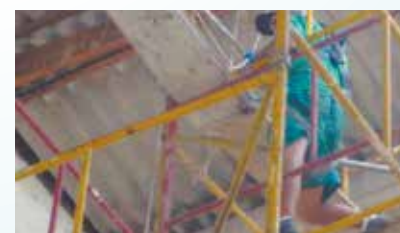
Reparos no telhado instituto Querô - Vila Nova
