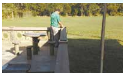
Reboco da mureta. Sociedade Esportiva de Caruara.
