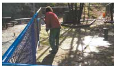
Pintura da tubulação da tela de alambrado da Pça. - Monte Cabrão
