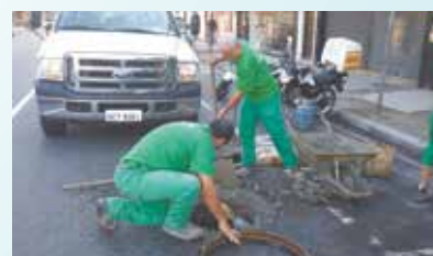
Substituição de poço de visita na Rua Senador Feijó - Centro
