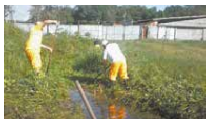
Desobstrução da vala de drenagem no KM 248 da Marginal - Monte Cabrão
