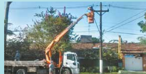
Manutenção elétrica na Travessa Padre Anchieta - Nova Cintra
