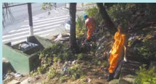
Limpeza de drenagem na Rua 1 - Boa Vista
