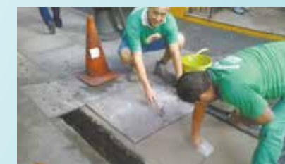
Troca de pisos e grelhas de granito no Boulevard da Rua XV de Novembro - Centro
