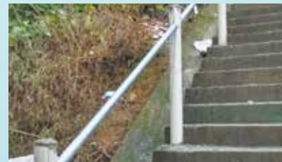
Instalação de corrimão na Vila Baiana - José Menino
