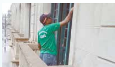
Pintura das janelas prédio Seges Rua Dom Pedro II esquina com General Câmara
