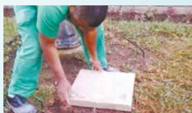
Troca de tampas de concreto Praça Mauá
