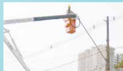
Reparo nas luminárias da Nova Cintra
