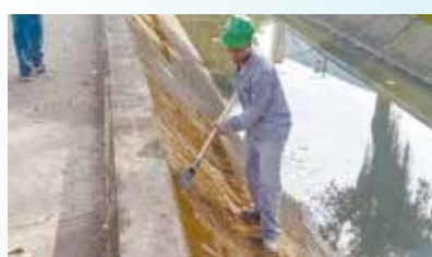
Lavagem do talude no canal 3 entre Carvalho de Mendonça e Joaquim Távora - Vila Mathias
