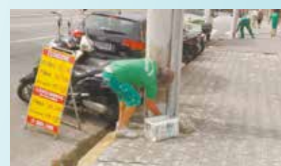
Pintura de meio fio e postes na Av. Afonso Pena
