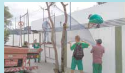
Retirada de tela de alambrado na UBS do Bom Retiro
