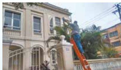
Instalação de seis refletores na UME José Bonifácio - Vila Nova
