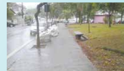
Retirada dos antigos cordoneis da Praça André Freire - Santa Maria
