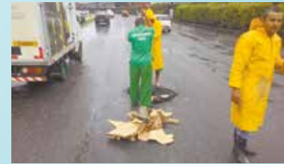
Renivelamento provisório de poço de visita na Av. Martins Fontes. Esperando melhora do tempo para execução definitiva - Valongo
