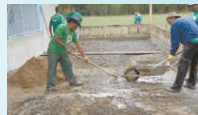
Pintura do salão, madeiramento das colunas, concretagem de piso e canteiro na Soc. Esp. de Caruara
