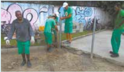
Chumbamento de estrutura para fixação de alambrado na Praça Guilherme Delius - Alemoa
