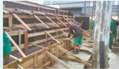
Continuação do madeiramento para concretagem da arquibancada na Praça Guilherme Delius - Alemoa
