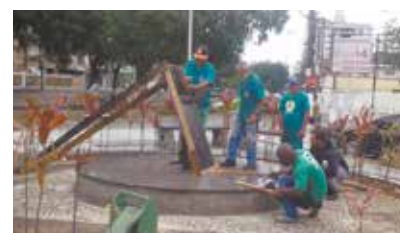
Manutenção da Praça André de Fazio - Marapé
