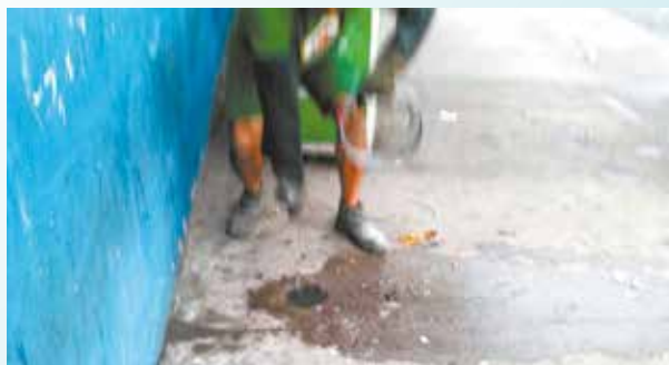
Desobstrução da rede de esgoto na UME Avelino da Paz Vieira - Vila Nova
