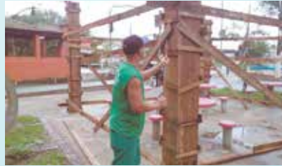
Desmontagem de formas dos pilares do quiosque na Praça Otávio Ribeiro - Vila São Jorge
