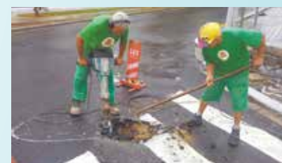
Reparo em Abatimento na Av. Siqueira Campos x Rua Germano Melchert - Embaré
