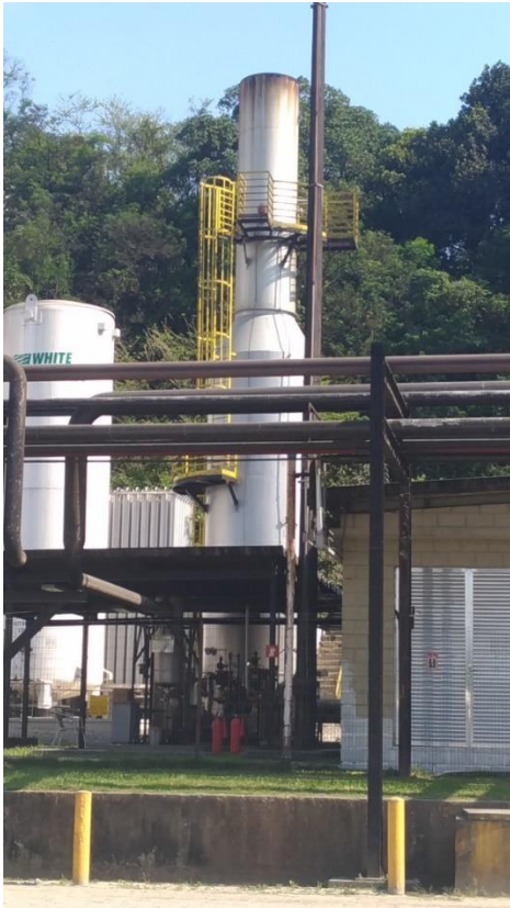
Figura 2.2 - 1: Foto da chaminé do sistema de controle das emissões atmosférica
