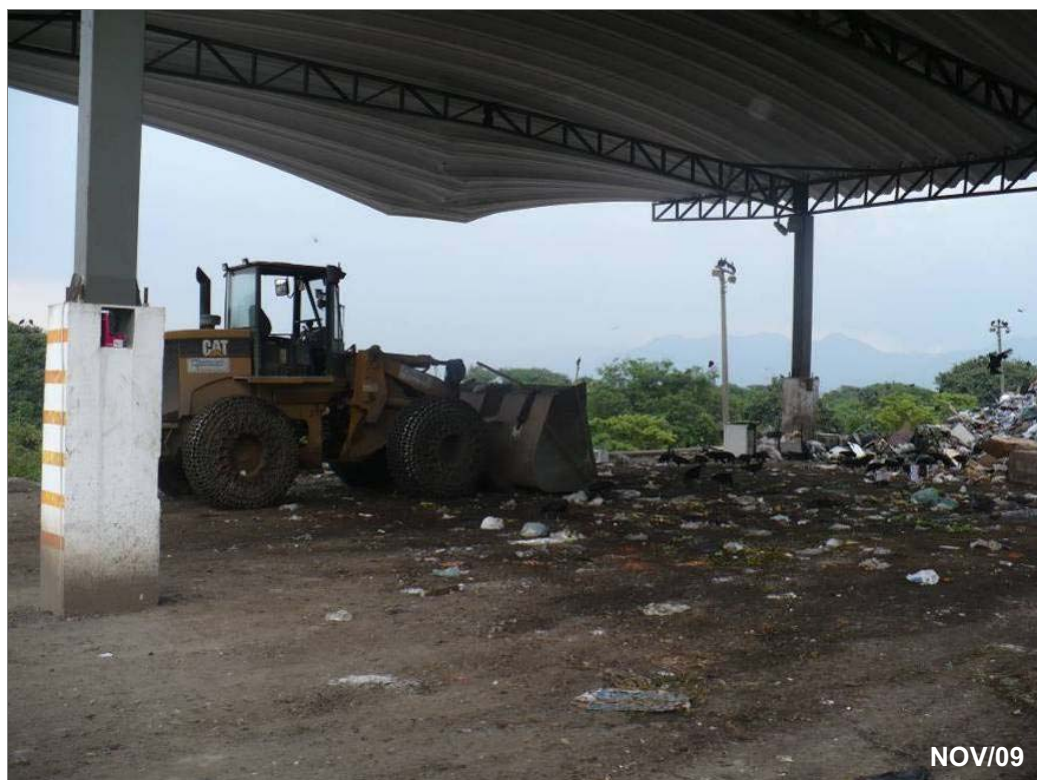
Figura 8.2 - Vista da estação de transbordo - Aterro da Alemoa. Fonte: Concremat.
