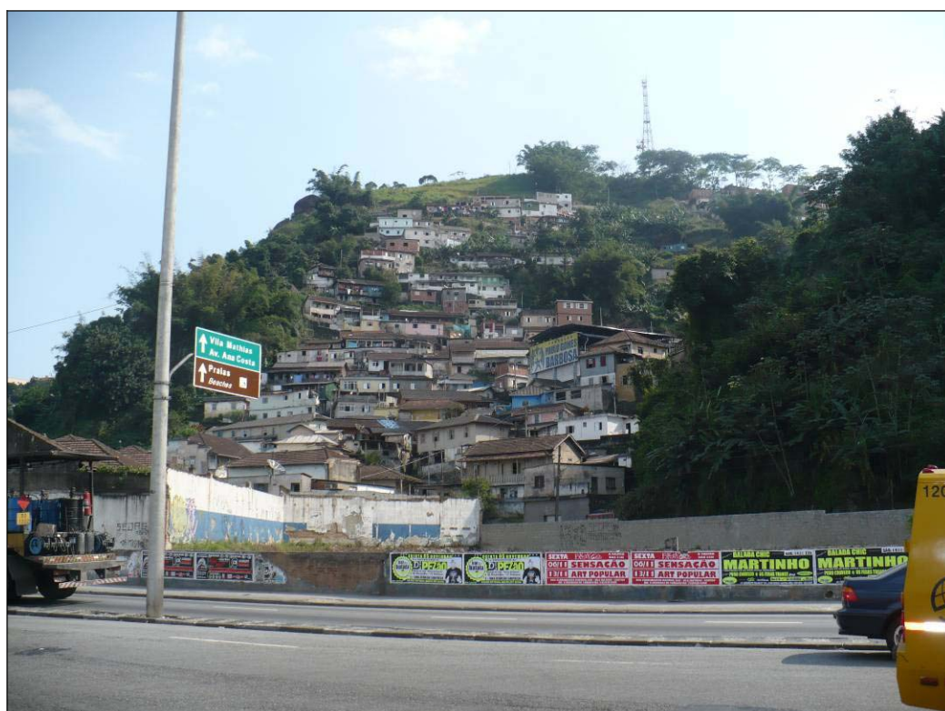
Figura 8.5 - Áreas de difícil acesso. Fonte: Concremat.
