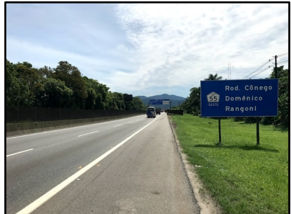
Figura 2.26 - Rodovia Cônego Domênico Rangoni, sentido Cubatão. A pista sentido Cubatão da SP-055 possui as mesmas características da pista sentido Guarujá.
