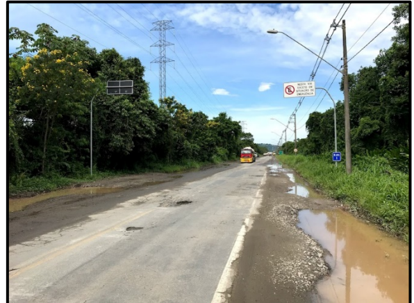
Figura 2.7 - Estrada Particular da CODESP, sentido Ilha Barnabé. A partir da SP-055, a via desenvolve-se em pista simples, com uma faixa de rolamento por sentido. Nota-se a partir da imagem acima, as condições de conservação do pavimento e das sinalizações horizontais, acostamentos.
