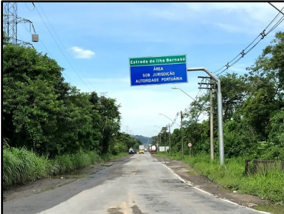
Figura 2.6 - Estrada Particular da CODESP. A imagem ilustra ainda o trecho inicial da via de acesso. A placa indica a jurisdição do trecho, delegada à autoridade portuária.
