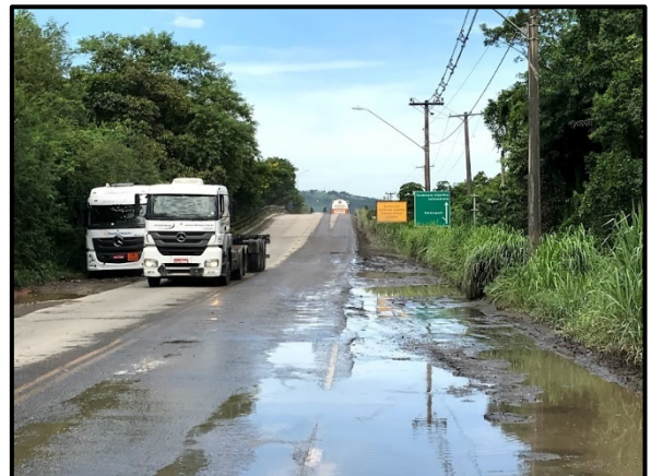
Figura 2.9 - Trecho inicial de Obra de Arte Especial (OAE) sobrepondo curso d’água existente no local. No total, a Estrada Particular da CODESP possui duas OAE’s.
