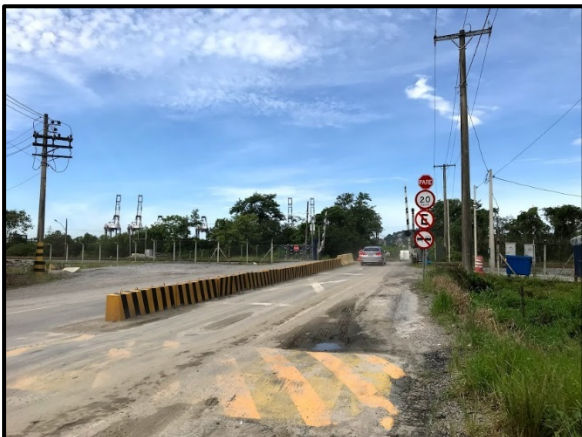
Figura 2.12 - Após aproximadamente 1.100 metros do pré-gate, encontra-se a passagem em nível sobre a ferrovia. A partir da imagem acima pode-se verificar que a PN encontra-se devidamente sinalizada, utilizando-se de cancelas automáticas e sinaleiras para o fechamento do tráfego rodoviário durante a passagem de composições ferroviárias.
