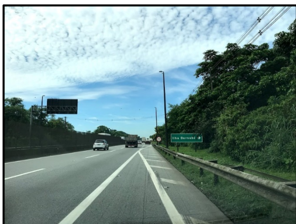
Figura 2.4 - SP-055 – Rodovia Cônego Domênico Rangoni, sentido Guarujá. A imagem mostra o acesso à Estrada Particular da CODESP, localizado no km 250+500m da SP-055.
