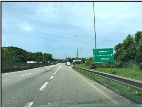
Figura 2.25 - SP-055, sentido Guarujá. No km 248 da rodovia, ou seja, aproximadamente 2,5 km do acesso à Ilha Barnabé está localizado o dispositivo de retorno da via. Este, possibilita que os veículos com viagem originada no terminal retomem o trajeto sentido Cubatão e demais localidades.
