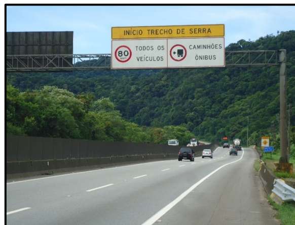
Figura 2.20 - SP-055, sentido Guarujá. A aproximadamente 5,5 quilômetros do acesso à Estrada Particular da CODESP inicia-se o trecho de serra da rodovia. Neste trecho a rodovia desenvolve-se com duas faixas de rolamento por sentido e sua velocidade máxima é regulamentada em 80km/h para todos os tipos de veículos.
