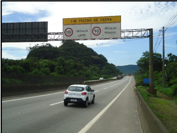
Figura 2.21 - SP-055 – Rodovia Cônego Domênico Rangoni, sentido Guarujá. Após o trecho de serra, que termina há aproximadamente 2,5 km do acesso à Estrada Particular da CODESP, as regulamentações de velocidade voltam às condições anteriores. Entretanto, a via mantém seu desenvolvimento com duas faixas de rolamento por sentido.
