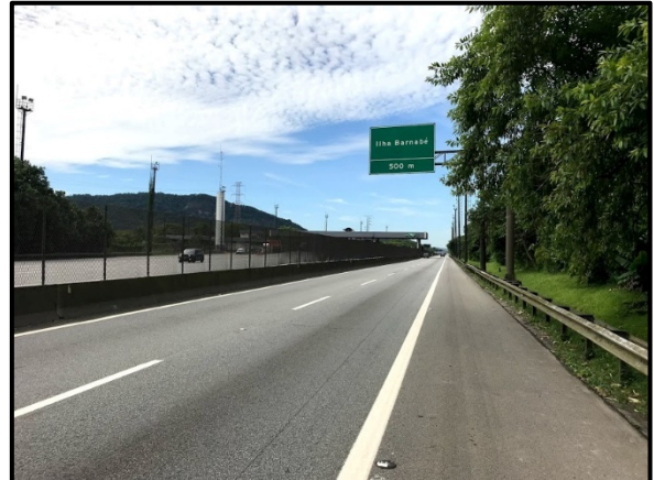
Figura 2.22 - SP-055, sentido Guarujá. A imagem mostra a sinalização vertical de indicação do acesso à Ilha Barnabé, localizado no km 250 + 500m da rodovia.
