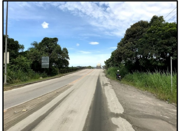
Figura 2.11 - Segunda Obra de Arte Especial (OAE) sobrepondo curso d'água existente no local.
