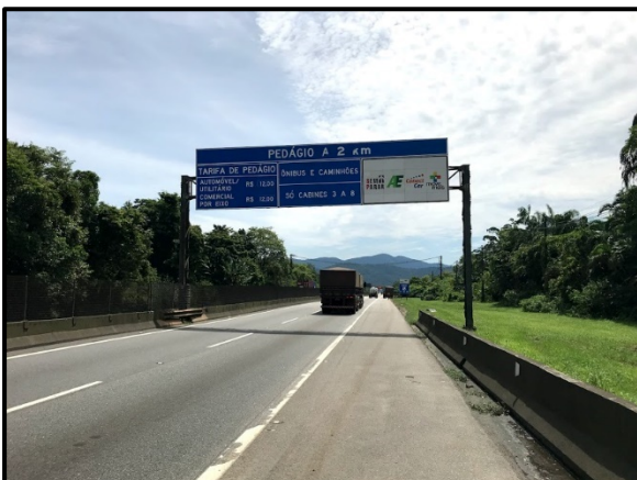
Figura 2.27 - SP-055, sentido Cubatão. Próximo ao acesso à Ilha Barnabé está localizada a praça de pedágio da rodovia. A cobrança é realizada apenas na pista sentido Cubatão e, atualmente, a tarifa encontra-se em R$ 12,00 para veículos de passeio e R$ 12,00 para veículos comerciais, por eixo.
