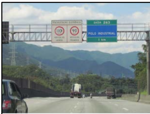
Figura 2.19 - Rodovia Cônego Domênico Rangoni (SP-055), sentido Guarujá, após o acesso à área urbana de Cubatão. Neste trecho a via desenvolve-se em pista dupla, com três faixas de rolamento por sentido. A via encontra-se em bom estado de conservação, com sinalizações horizontais e verticais adequadas. Sua velocidade máxima está regulamentada em 110Km/h para veículos leves e 90km/h para veículos pesados.
