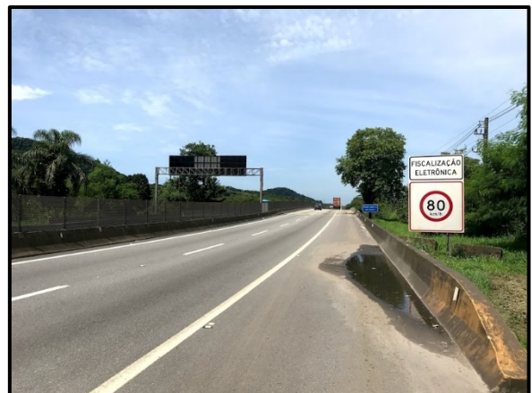
Figura 2.24 - SP-055, sentido Guarujá, após o acesso à Ilha Barnabé. Após o acesso, a via possui regulamentação de velocidade máxima em 80 km/h.
