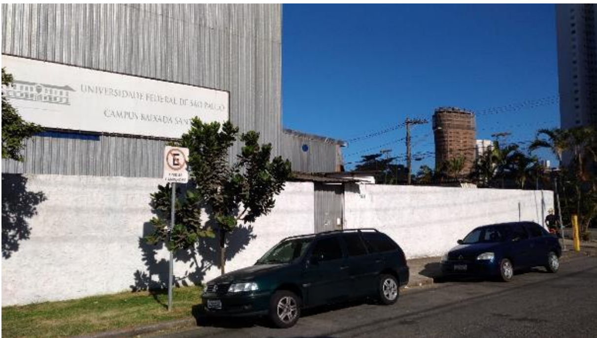
Figura 5.3-7 – Galpão da UNIFESP na Rua Maria Máximo.
