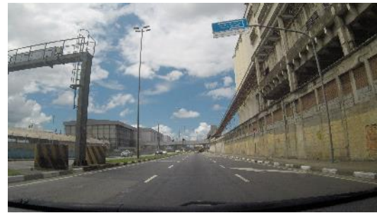
Foto 2.12. | Observa-se ao longo de toda a Avenida Cidade de Santos boas condições de sinalização horizontal e vertical.
