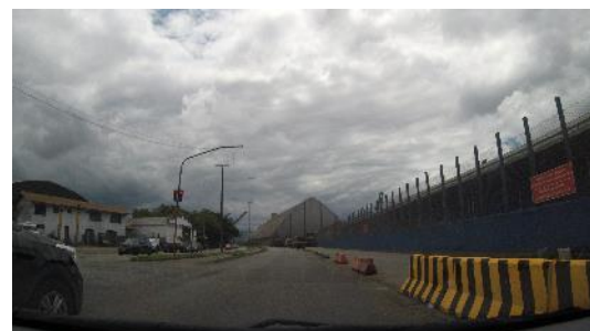
Foto 2.6. | Avenida Mario Covas Jr, pista norte. Neste sentido a via possui as mesmas características já apresentadas. A direita da foto nota-se uma faixa adicional, separada por elementos físicos (barreiras tipo Jersey). Tal faixa é utilizada por veículos de carga com destino ao TES.
