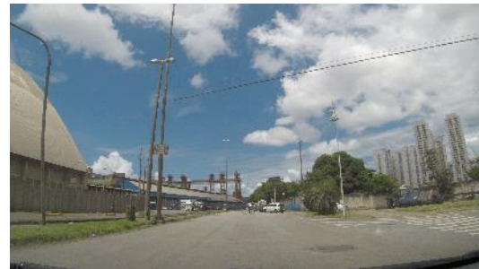
Foto 2.4. | Avenida Mario Covas Jr, pista Sul. Ao fundo da foto à esquerda visualiza-se o empreendimento em estudo. À direita o entroncamento da Av. Afonso Pena com a Av. Mario Covas Jr.
